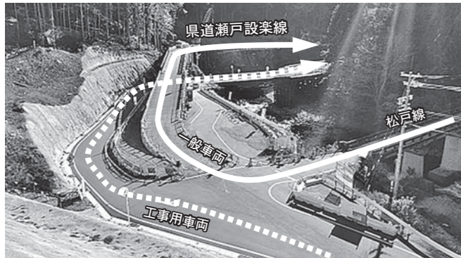
⑨ H31 設楽ダム工事用道路迂回路整備工事 ・松戸橋付近で一般車両と工事用車両を分離するための工事を施工中です。
