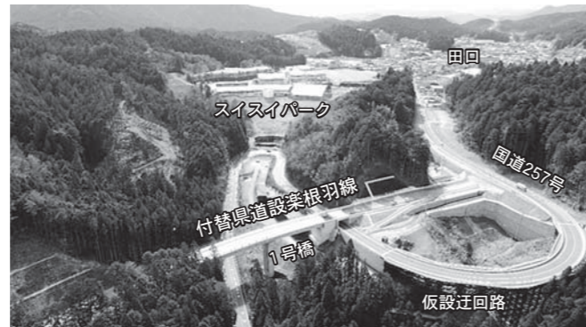
⑤ H31 設楽ダム設楽根羽線整備工事 ・1号橋上部工が1月に完成しました。今後、舗装・道路付属物などの工事を行う予定です。
