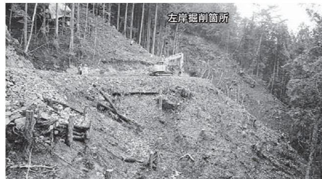
⑰ R 1 設楽ダム本体左岸掘削工事 ・ダム本体を施工するための本体左岸掘削工事を施工中です。
