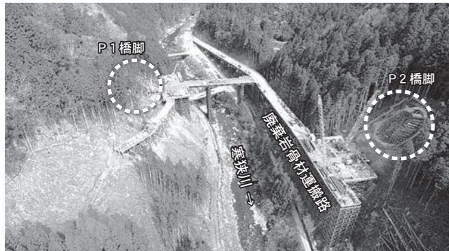
①② H29 瀬戸設楽線 5号橋右岸・左岸下部工事 ・付替県道瀬戸設楽線 5号橋の橋脚の基礎工事を施工中です。
